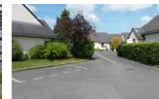
Amélioration des logements locatifs de la mairie, création d'un logement d'urgence
