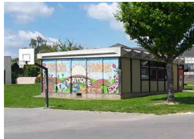
Dans le cadre des dépenses de fonctionnement, il sera procédé à la démolition du préfabriqué situé dans la cour de l'école élémentaire publique (35 000,00 €).
