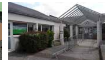
En cette année 2022, c'est la maternelle qui va être rafraîchie par la mise en peinture du couloir, et la remise aux normes de son tableau électrique (35 000€)
